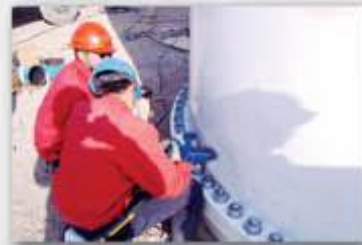
JHF型液压扳手在安装 风力发电机现场
