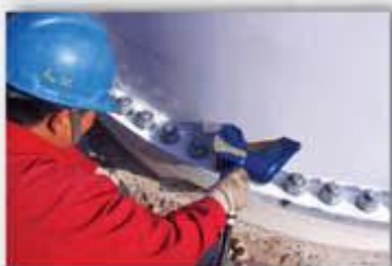
JHM型液压扳手在新疆 风力发电安装现场
