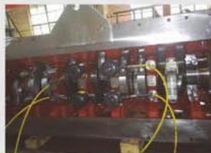
在大型船用柴油机安装现场3
