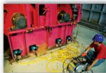
JHM型液压扳手在冷轧薄板 轧机安装现场四同步使用
