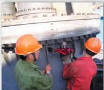
JHM型液压扳手在高温高压 加氢反应器安装现场
