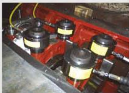
在大型船用柴油机安装现场1
