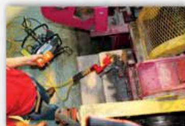
JHX中空液压扳手在 减速机安装现场应用
