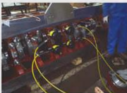
在大型船用柴油机安装现场2
